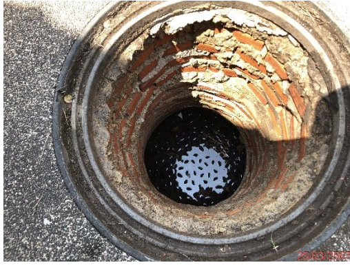
บ่อกักน้ำทิ้งก่อนผ่านระบบบำบัดน้ำเสียอาคารที่พักผู้โดยสาร
